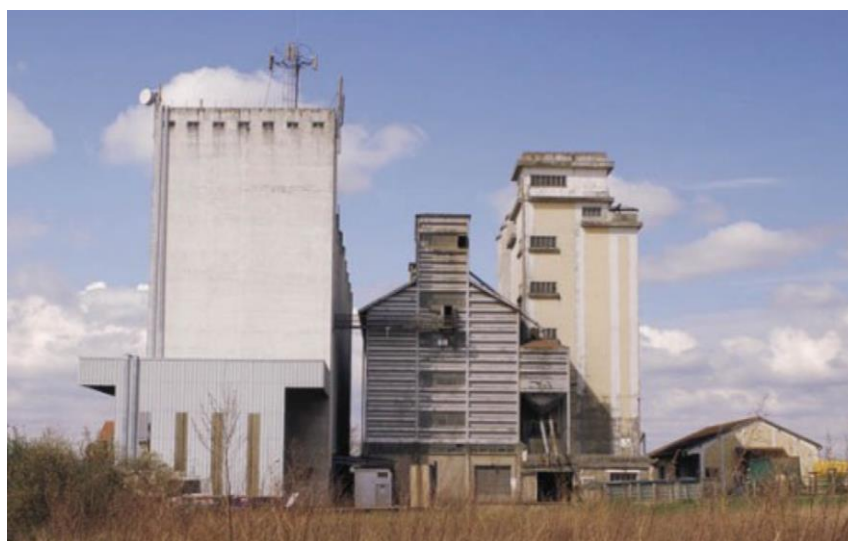
Figure 22 : Silos de la coopérative VALFRANCE à Rozay-en-BRIE
